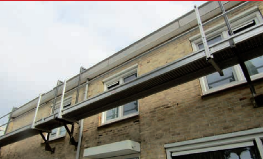
Door Verkoelen Weert zelf ontwikkelde steigervoorziening overlastbeperkend voor bewoners.
