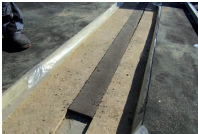
Ontkoppeld dakbeschoot opgevuld met perlietboard.
